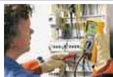
Test izolace na deskovém rozvaděči
