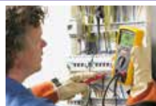
Test izolace na deskovém rozvaděči
