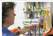
Test izolace na deskovém rozvaděči
