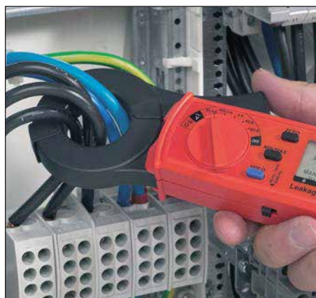
Differenzstrommessung mit Leckstromzange
